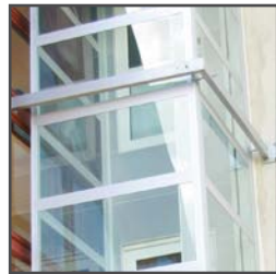
Krans om de lift voor extra stabiliteit
